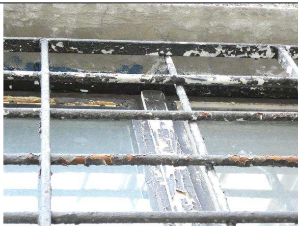
Fot. nr 6. Stan stolarki okiennej drewnianej i krat na el. od podwórka
